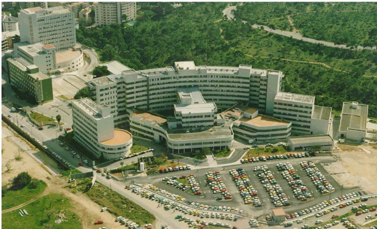
VISTA AEREA DEL ESTADO ACTUAL EN LA QUE SE APRECIAN LAS DISTINTAS EDIFICACIONES Y EL GRAN PABELLON CENTRAL CON FORMA CURVA
