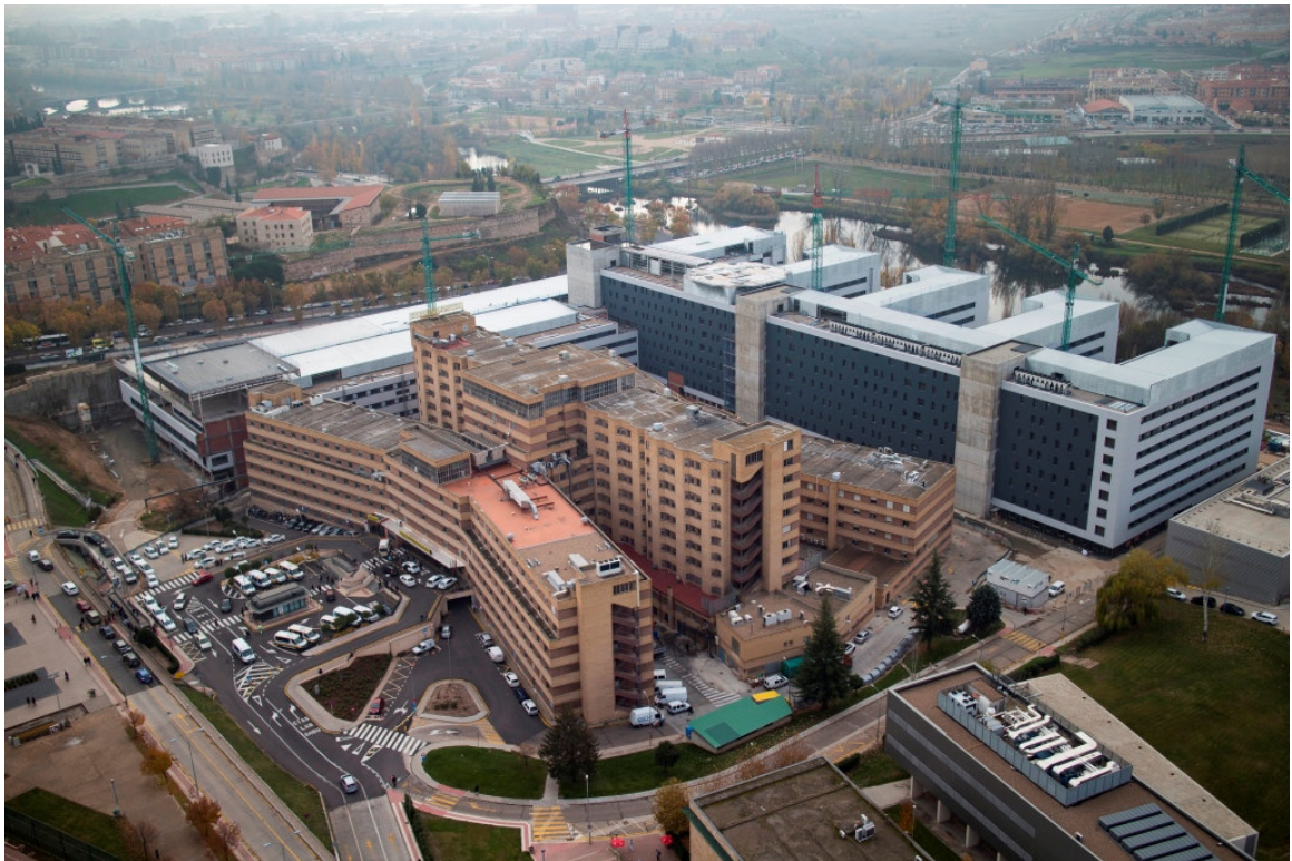
VISTA DE LAS OBRAS DEL NUEVO HOSPITAL EN LAS QUE SE APRECIA COMO SE MANTIENE EL ANTIGUO EDIFICIO
