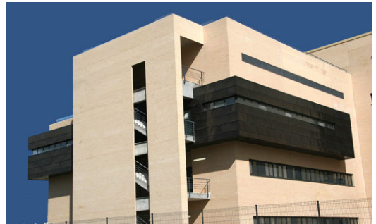
FACHADA PRINCIPAL Y POSTERIOR DEL HOSPITAL. NÚCLEO DE PASILLOS CHAPADO CON COBRE
