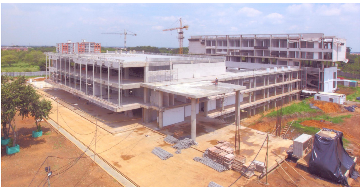
VISTA DE CONJUNTO DEL NUEVO HOSPITAL
