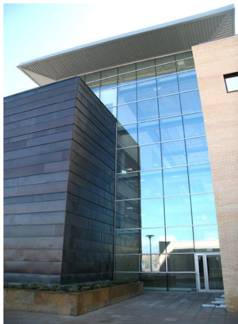
DETALLE DEL ENCUENTRO ENTRE LA FACHADA CERAMICA, EL MURO CORTINA Y EL CHAPADO EN COBRE
