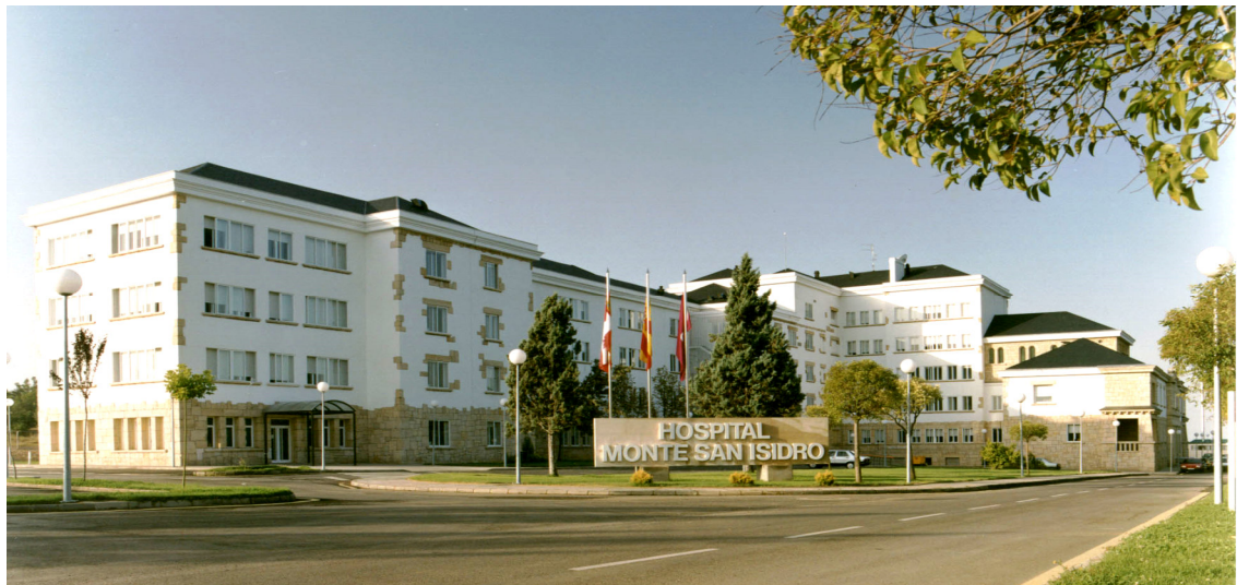
VISTA DESDE ACCESO AL RECINTO
