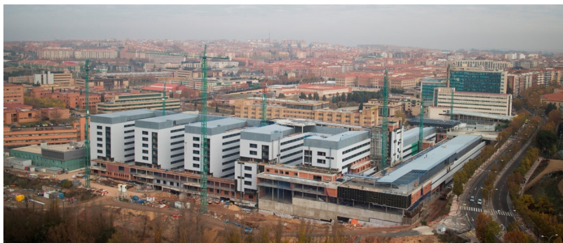
ESTADO ACTUAL DE LAS OBRAS ACCESO A LAS URGENCIAS Y VISTA DE LOS NUCLES DE HOSPITALIZACION
