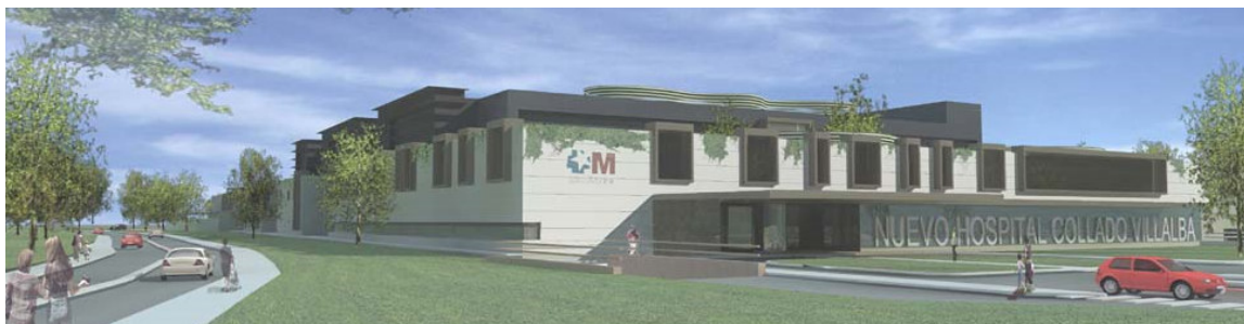
ACCESO PRINCIPAL AL NUEVO HOSPITAL
