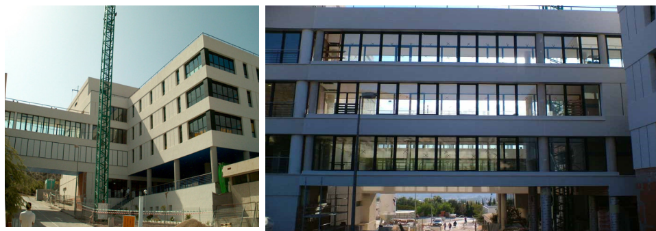
PASARELA DE COMUNICACIÓN ENTRE LOS DISTINTOS NÚCLEOS
