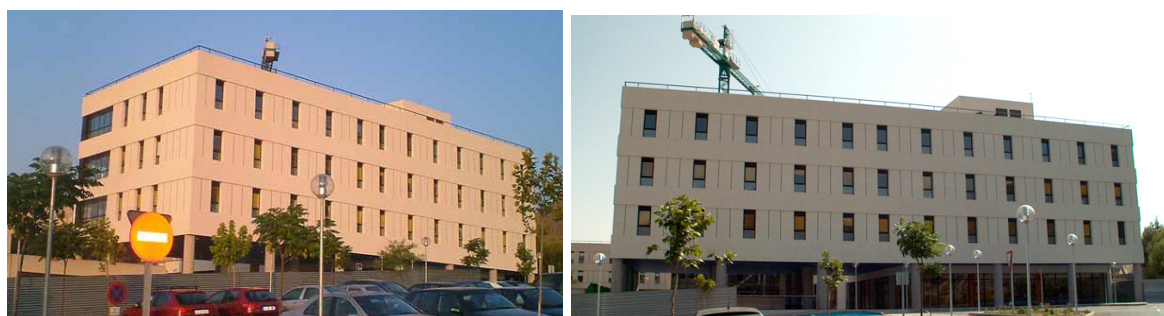
DISTINTAS VISTAS DE LAS FACHADAS EN LAS QUE SE APRECIA EL MOVIMIENTO DE LAS MISMAS
